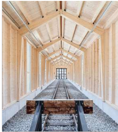
Lokremise in Zweisimmen: Blick in Richtung Einfahrtstor.
