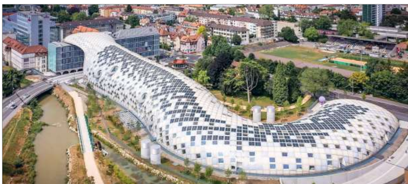
Luftbild des Geländes der Swatch Group in Biel: Eine öffentliche Strasse teilt die zwei Grundstücke von Swatch und Omega.
