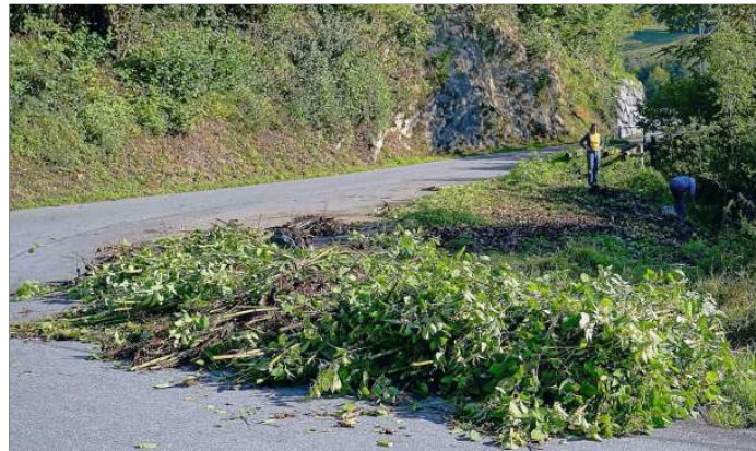
Das Werk ist vollbracht: Die Fläche am Ruersgraben ist vom wuchernden Japanischen Staudenknöterich befreit und die Abschnitte sind gebündelt für den Abtransport vorbereitet.
