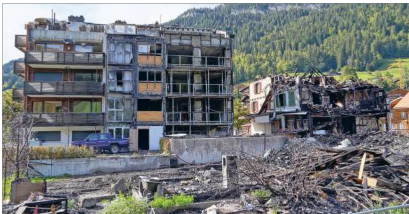
In der Waschküche des Ökonomieteils ist der Brand ausgebrochen (vorne Bildmitte).
